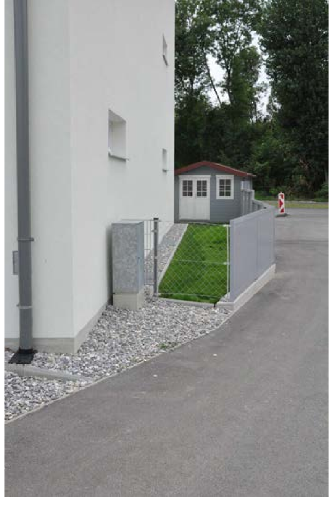
Ebenfalls befremdend ist, dass die wuchtigen Einfahrten zu den Garagen zwischen die Wohnbauten hineingezwängt wurden – als ob der Platz hier nicht besser für größere Privatgärten Verwendung finden hätte können.
